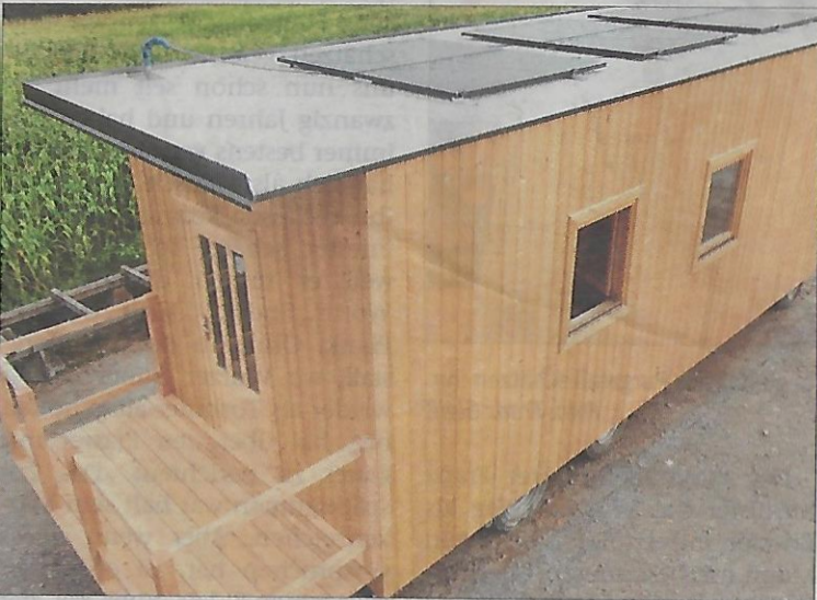
Der erste der autarken Wohnwaggons, die bald auf Esperanza stehen sollen, ist bereits in Bau. Gebaut und gesponsert wird der Waggon von Tischler Christian Grenl aus Mank. Foto: Gerhard Rötzer
